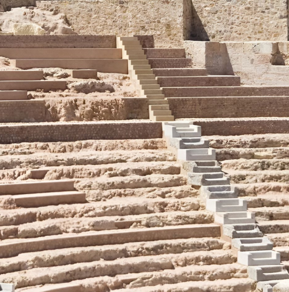
12 Dettaglio dell'intervento progettuale sulla cavea e sulle scale radiali del teatro e della tecnica costruttiva del muro perimetrale dell'emiciclo (©G. Cavallina)
